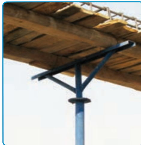
شکل ۲۱-۳- استفاده از شمع‌های فلزی جهت نگهداری قالب‌ها
