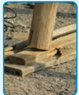
شکل ۲۵-۳- استفاده از گوه جهت تنظیم ارتفاع
