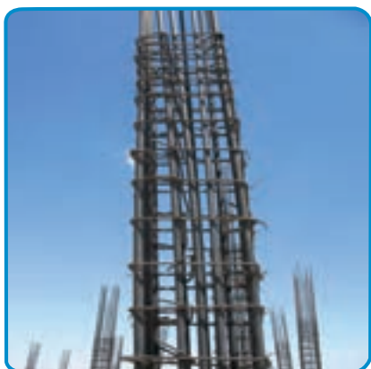
شکل ۱۹-۷- کار گذاشتن میلگردهای انتظار ستون، در فونداسیون
