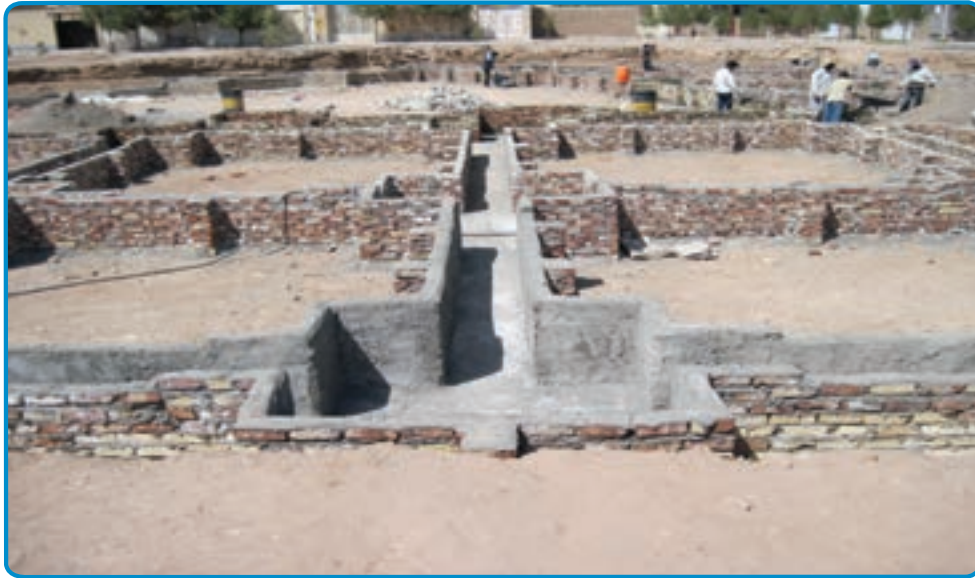
شکل ۳-۲۹- قالب آجری برای اجرای پی
