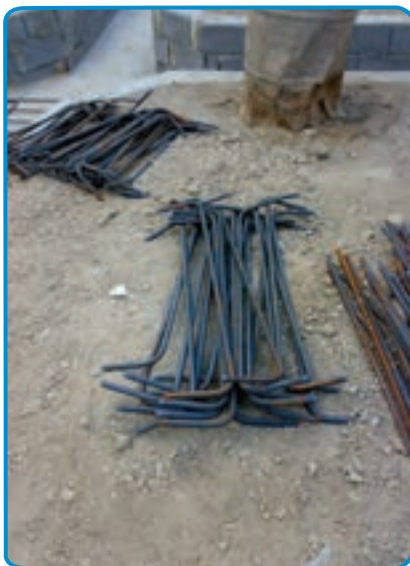
شکل ۷-۷- آماده کردن میلگردهای طولی و عرضی
