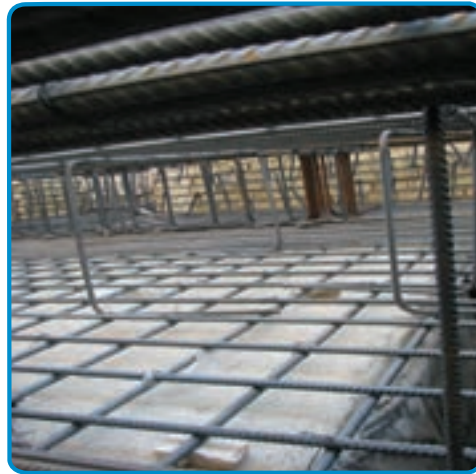
شکل ۳-۵۳ - استفاده از خرک در میلگرد گذاری پی
