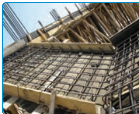
شکل ۳۸-۷- اجرای میلگردهای دال پله
