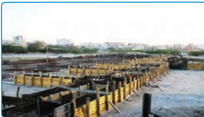
شکل ۳-۲۷- قالب چوبی برای اجرای پی
