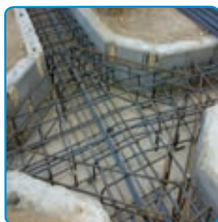
شکل ۱۴-۷- تکمیل میلگردگذاری محل اتصال ستون
