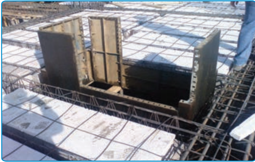
شکل ۳۵-۷- تکمیل قالب بندی
