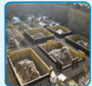
شکل ۳-۳۱- قالب فایبرگلاس برای اجرای پی
