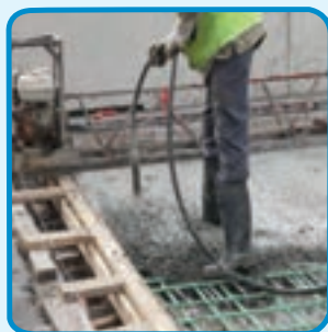
شکل ۱۴-۳- ویبراتور یا لرزاننده بتن داخل قالب
