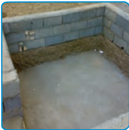
شکل ۱-۷- آماده سازی کف پی
