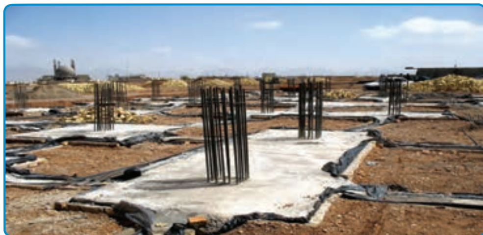
شکل ۱۰-۳- استفاده از پلاستیک در پی
