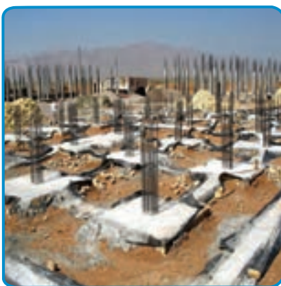
شکل ۱۷-۷- اجرای خاموت و سنجاقک
