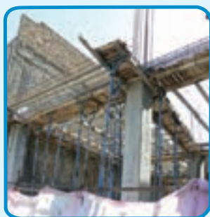
شکل ۳-۳۹- استفاده از قالب چوبی برای اجرای تیر
