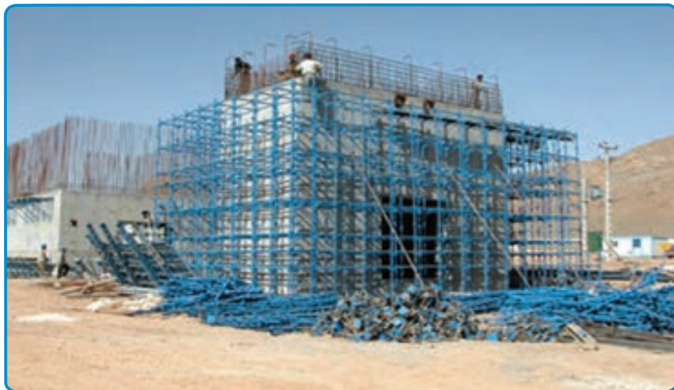
شکل ۳-۲۶- داربست فلزی
