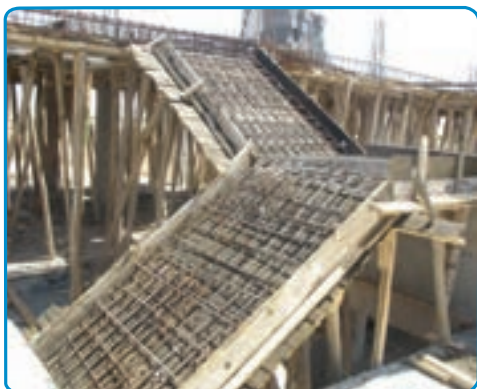
شکل ۳۹-۷- اجرای میلگردهای دال پله
