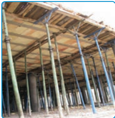
شکل ۲۱-۳- استفاده از شمع‌های فلزی جهت نگهداری قالب‌ها
