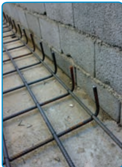
شکل ۱۰-۷- رعایت پوشش بتن در کف و بدنه
