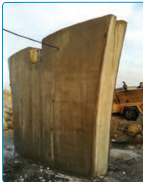
شکل ۳-۴۲- قالب برداری
