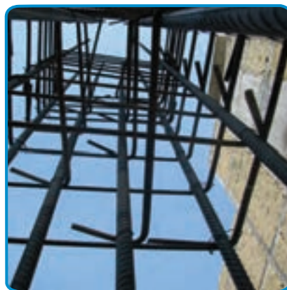
شکل ۱۹-۷- کار گذاشتن میلگردهای انتظار ستون، در فونداسیون
