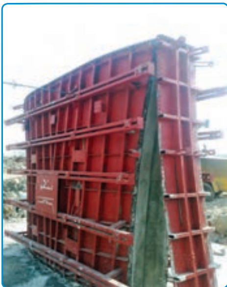
شکل ۳-۴۲- قالب برداری
