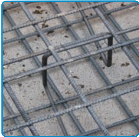
شکل ۳-۵۳ - استفاده از خرک در میلگرد گذاری پی
