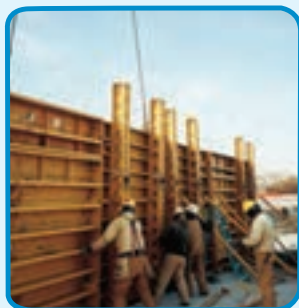
شکل ۳-۳۶- قالب فایبر گلاس برای اجرای دیوار بتنی
