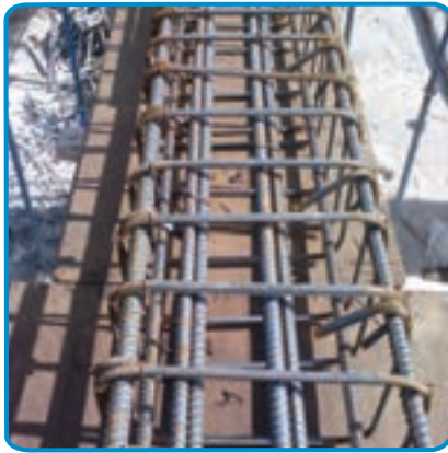
شکل ۷-۲۵- بستن خاموت ها با مفتول
