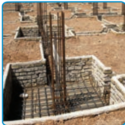
شکل ۴-۷- اجرای میلگردهای ریشه انتظار
