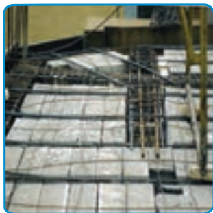
شکل ۷-۳۲- اجرای تیرهای فرعی کنسول
